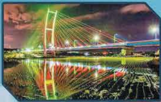
{Steel Structure Bridge Project} 鋼構橋樑工程
